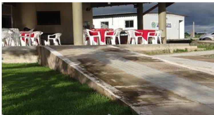
Figura 3: Rampa para o acesso ao espaço da lanchonete na unidade III
